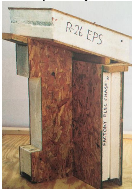
Figur 1 Typiskt utformade SIPS-element, med kärna av EPS och sidor av OSB. Här visas hur en skarv mellan väggar och tak kan tänkas se ut. Källa: M. Morley, Building with Structural Insulated Panels , Berkeley: Publishers Group West, 2000.
